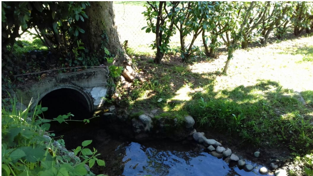
Foto 7- Tratto a cielo aperto della Roggia Roncaglia lungo la via Montanelli
