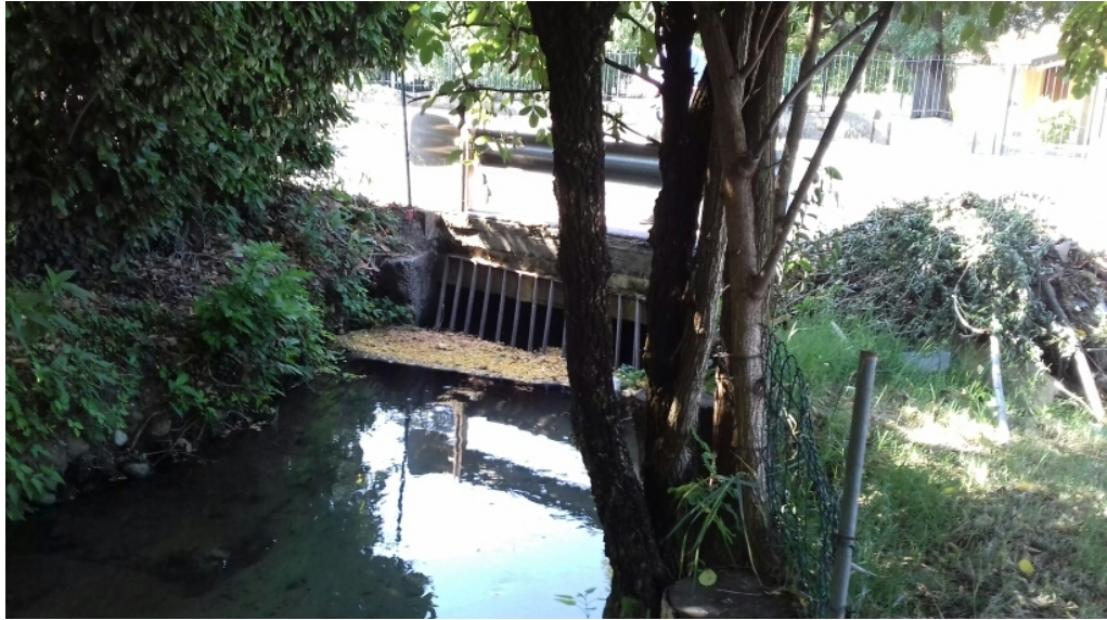
Foto 10 Tratto a cielo aperto della Roggia Pedrenga in via Piave
