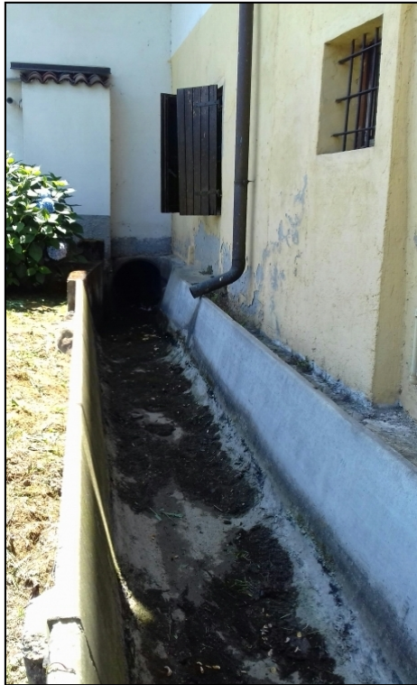
Foto 6- Tratto a cielo aperto in canale prefabbricato della Roggia Roncaglia presso l'azienda agricola Palamini
